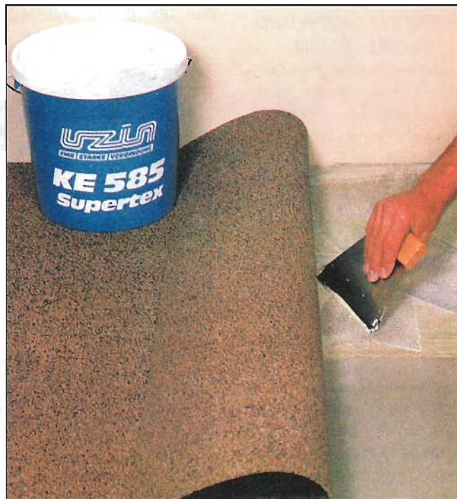
Откинув вверх часть полосы, наносят клей на освободившийся участок пола, разравнивают его и дают ему небольшую выдержку.
