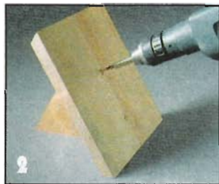
К основанию шурупами крепят треугольную подпорку, совмещая ее спереди с кромкой основания.
