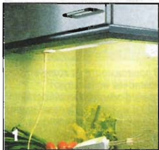
Планки укрывают розетку и лампу под настенными шкафами.
