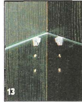
13 Стеклянные полки опираются на прозрачные полкодержатели. Чтобы полки случайно не сползли с полкодержателей (например, во время чистки), их крепят к опорной поверхности последних двухсторонней самоклеящейся лентой.
