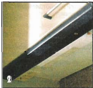
Розетку и лампу устанавливают вплотную к загораживающим их планкам.
