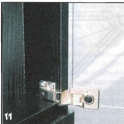
11 Чтобы установить петли на стеклянную дверку, сверлить отверстия в стекле не требуется — их крепят на зажимах. Основание петель привинчивают изнутри к боковым нащельникам.
